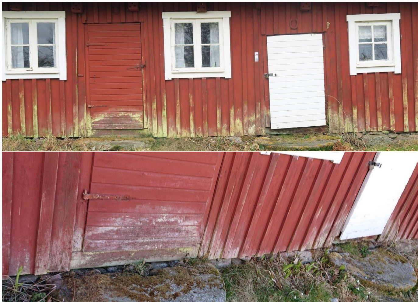
Den övre bilden visar fasaden före behandlingen och den nedre efter den andra behandlingen
