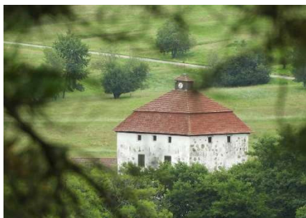
Utom tävlan – Hovdala torn från fjärran
